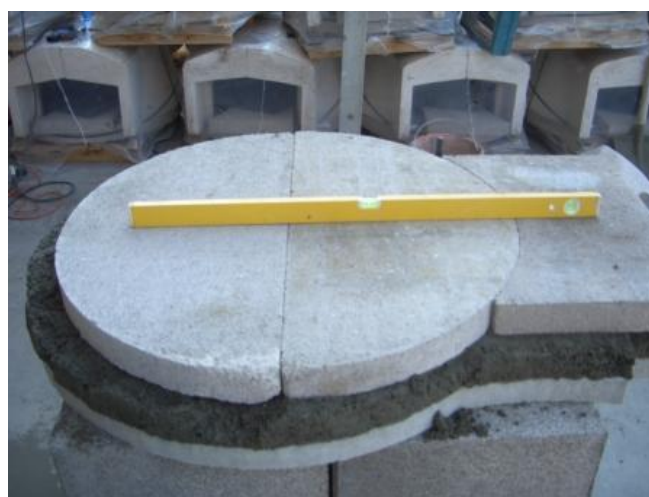
Appoggio delle basi del forno con controllo tramite livella bolla
